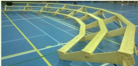
*Système de gradins facilement (dé)montable pouvant accueillir 50 personnes assises, ne nécessitant pas un grand espace de stockage*
